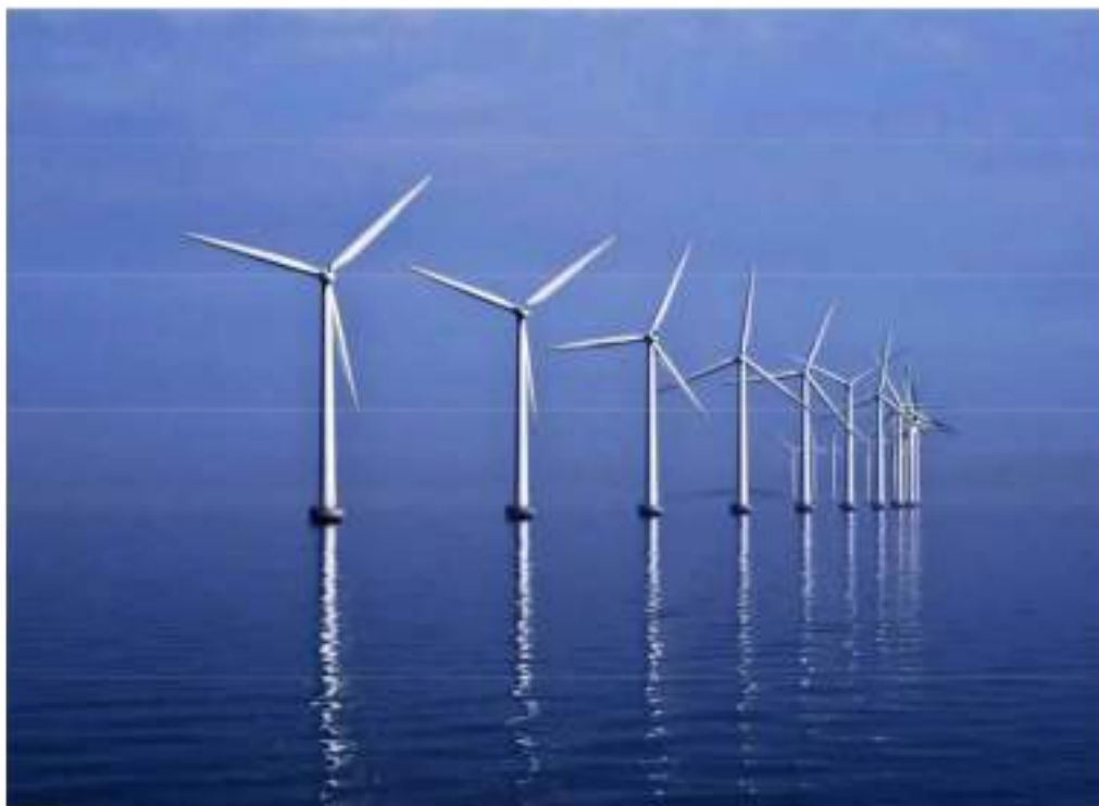
Figura 10: Distribución de 72-kilovoltios está siendo considerado para campos eólicos marítimos.
