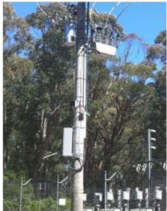
Figura 7: Redes eléctricas inteligentes requieren alimentadores bidireccionales como este modelo para montaje de poste de NOJA Power.
